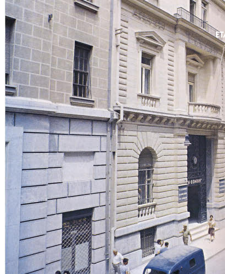
Αριστερά, το κτήριο της οδού Σοφοκλέους, δεξιά το Μέγαρο της οδού Καραγεώργη Σερβίας
