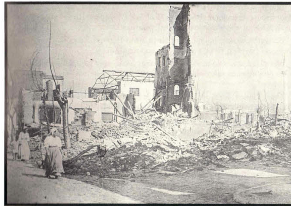
Επάνω: Ερείπια στην Εγνατία οδό Κάτω: Ερείπια στο κέντρο της πόλεως. (Φωτογραφίες από το βιβλίο του Ηλία Πετρόπουλου: "Θεσσαλονίκη, η πυρκαγιά του 1917.")
